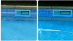
Wasserlinie am Beckenrand
