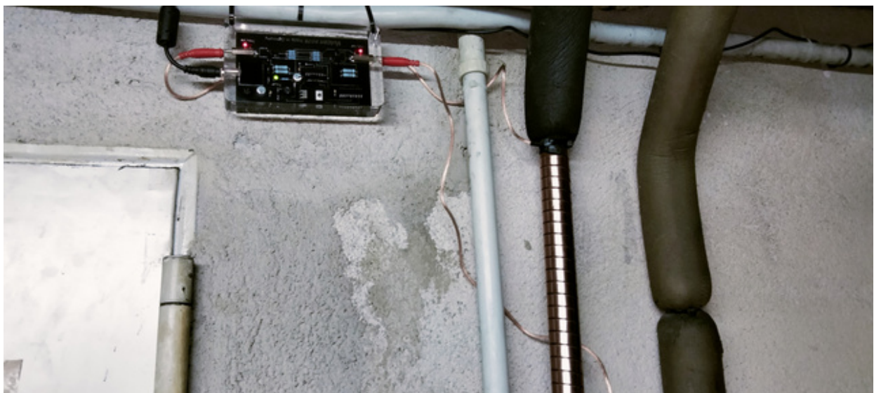
1 x Vulcan 5000 im Heiswasser Kreislauf
