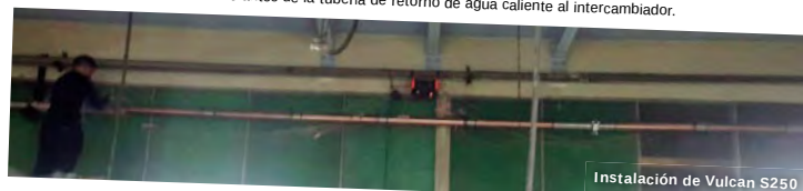
Instalación de Vulcan S250
