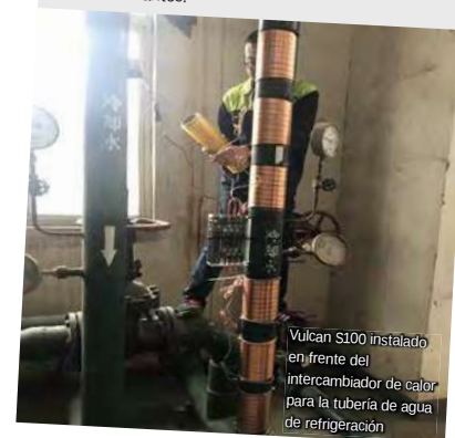
Vulcan S25 instalado en frente del intercambiador de calor para la tubería de agua de refrigeración
