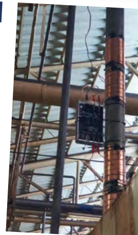
Vulcan S25 se instaló unos 50 metros antes de la máquina de temple por inducción.
