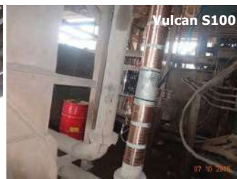
Intercambiador de calor tras 2 meses con Vulcan
