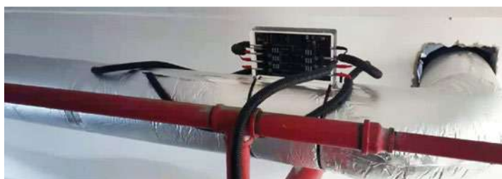
1 equipo Vulcan S100 instalado en el calentador de agua de la bomba de calor de aire en el edificio de apartamentos 2
