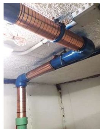
Paso 1: Se instalaron las bandas de impulso
