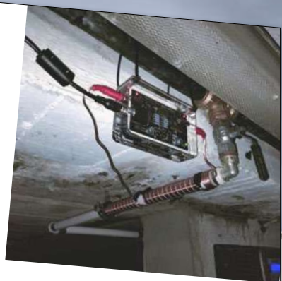
Vulcan 3000 En el tubo del depósito de agua con Ø 25mm
