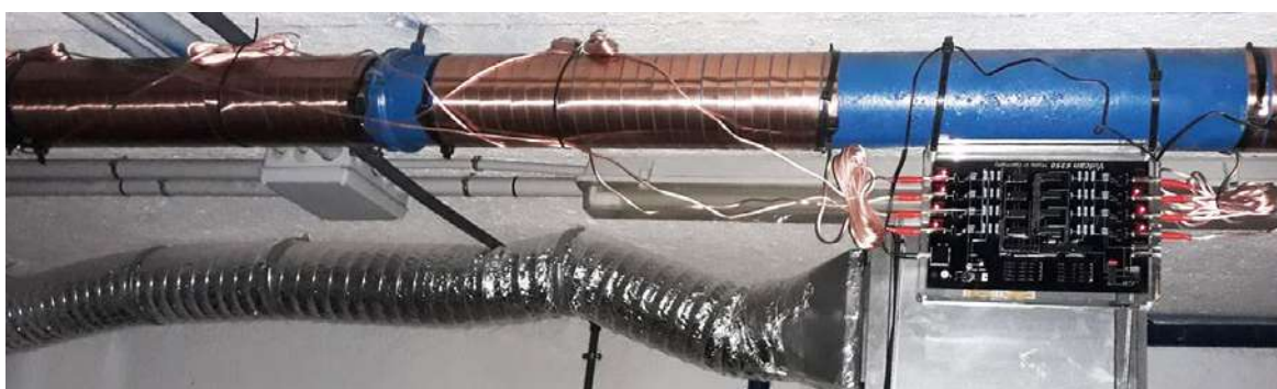
Paso 2: Se instaló la unidad S250 en la tubería principal de agua
