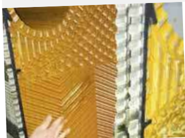
El agua proviene de un pozo subterráneo. Se instaló una unidad Vulcan S500 tras limpiar la placa del intercambiador de calor. Luego de 4 meses no se observaban más depósitos de cal blancos y solo quedaba óxido amarillento. Aunque aún habían sustancias en la placa, estas se ablandaron.
