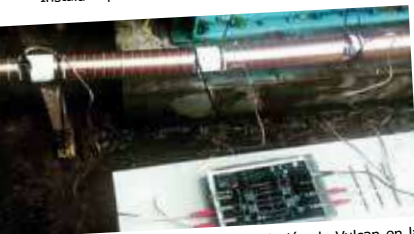
Foto 1. Procedimiento de instalación de Vulcan en la tubería principal de entrada del agua.
