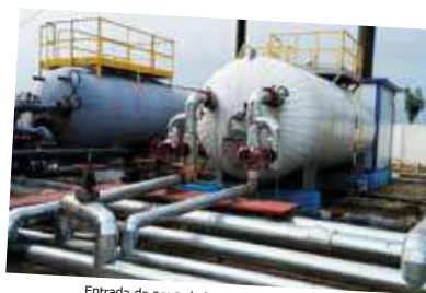
Entrada de agua de la calefacción del horno.
