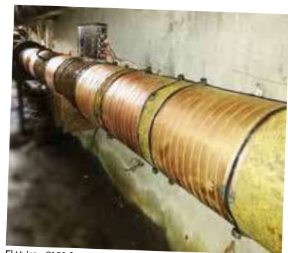
El Vulcan S150 fue instalado en la tubería principal para el edificio de oficinas y el dormitorio.
