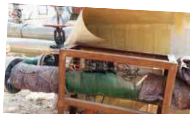
Antes de instalar Vulcan, se extrajeron el óxido y el aislamiento de la tubería. Las bandas impulsoras se enrollaron alrededor del tubo y se colocó nuevamente el aislamiento.
