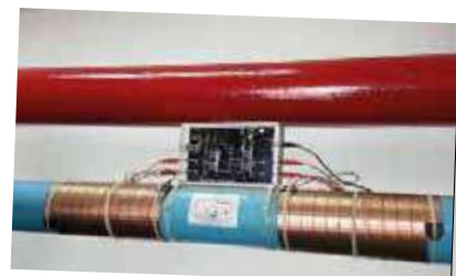
Instalación del sistema Antical Vulcan S25
