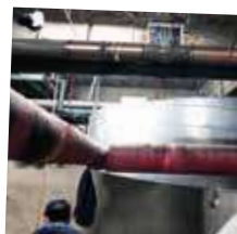
Vulcan S25 instalado en una tubería de cobre DN80.
