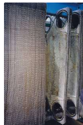
Intercambiador de calor de placas
