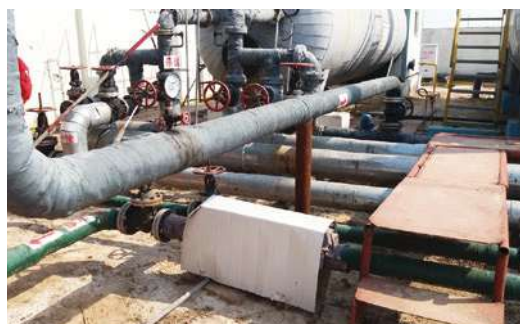
Instalación en el exterior con una cubierta hecha a medida para proteger la unidad del viento y el sol.
