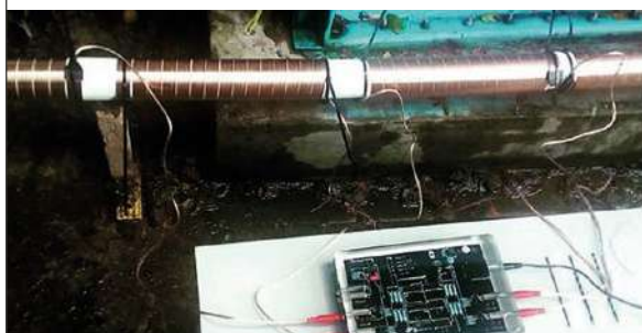
Foto 1. Procedimiento de instalación de Vulcan en la tubería principal de entrada del agua.
