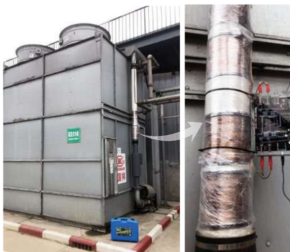
Vulcan S25 instalado en la entrada de agua de la torre de enfriamiento.
