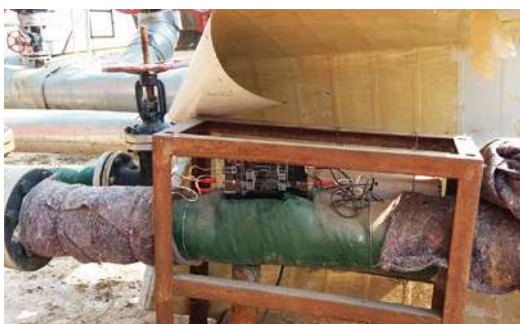
Antes de instalar Vulcan, se extrajeron el óxido y el aislamiento de la tubería. Las bandas impulsoras se enrollaron alrededor del tubo y se colocó nuevamente el aislamiento.
