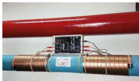
Instalación del sistema Antical Vulcan S25
