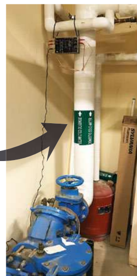
Paso 2: se instaló el equipo S25 en el conducto de agua y se cubrió con la capa protectora
