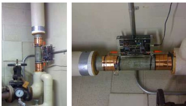
Instalación del desincrustante Vulcan para el suministro de agua general de los edificios de la escuela Roosevelt.
