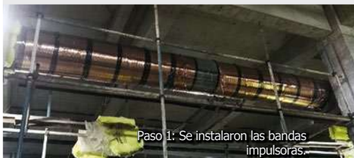
Paso 1: Se instalaron las bandas impulsoras.
