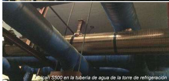
Vulcan S500 en la tubería de agua de la torre de refrigeración
