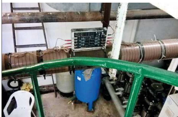
Se instalaron dos equipos Vulcan S100
