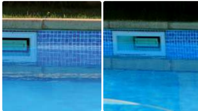
Tubería de agua en una piscina
