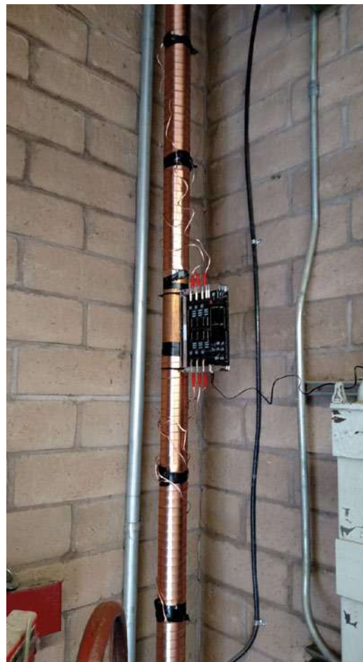
Vulcan S100 an der Hauptwasserleitung installiert
