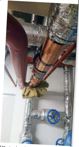
Un equipo Vulcan S50 en la entrada principal de agua del Edificio A.
