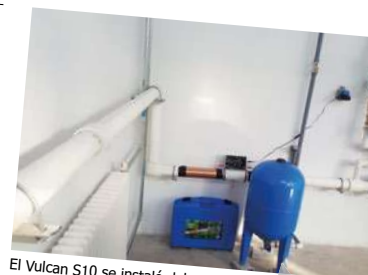
El Vulcan S10 se instaló delante del calentador de agua.
