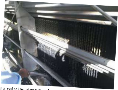
La cal y las algas pueden retirarse fácilmente con una pistola de agua.
