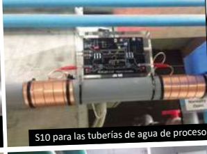
Bandas impulsoras recubiertas de aislamiento para tuberías
