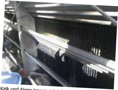
Kalk und Algen lassen sich leicht mit einer Wasserpistole entfernen.
