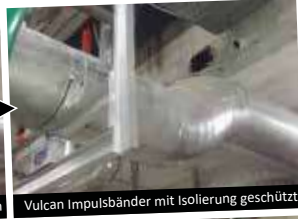
Vulcan S500 für das Kühlsystem
