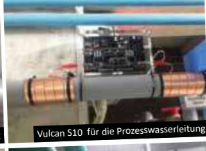
Vulcan Impulsbänder mit Isolierung geschützt
