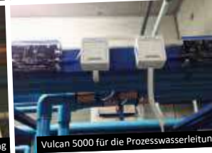
Vulcan Impulsbänder mit Isolierung geschützt
