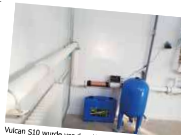
Vulcan S10 wurde vor dem Warmwasserbereiter installiert.
