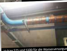
Vulcan S25 und S100 für die Wasserversorgung
