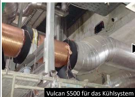
Vulcan Impulsbänder mit Isolierung geschützt
