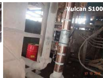
Wärmetauscher nach 2 Monaten mit Vulcan.
