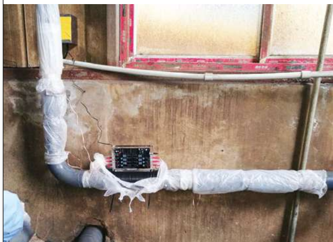
Vulcan S100 wurde im Abwasserraum installiert, um die Schlammmentwässerungsmaschine zu behandeln.
