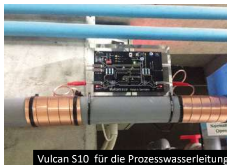
Vulcan Impulsbänder mit Isolierung geschützt
