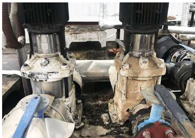
Links ist das Rohr ohne Kalk nach der Installation von Vulcan S25, nach 2 Monaten; rechts ist das Rohr ohne jegliche Wasserbehandlung.
