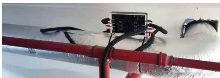
Ein Vulcan S100 ist für den Warmwasserbereiter der Luftwärmepumpe in Wohnhaus 2 installiert.
