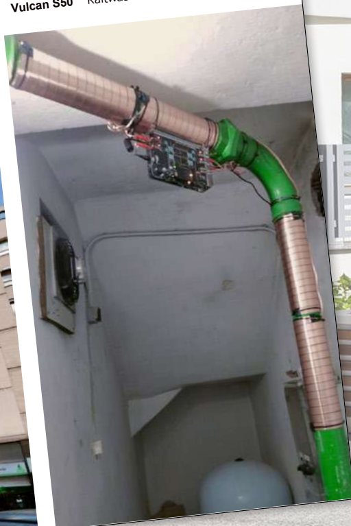
Vulcan S50 Kaltwasser Hauptleitung mit Ø 76 mm
