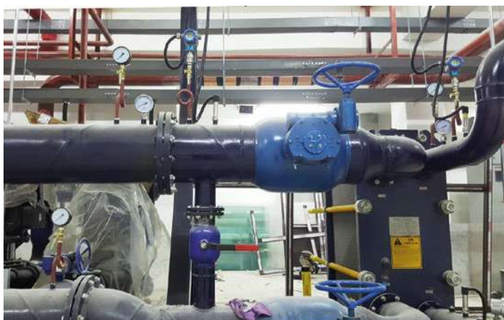
Vulcan S150 wurde im Heizsystem des unteren Bereichs in der Wärmetauschstation installiert.
