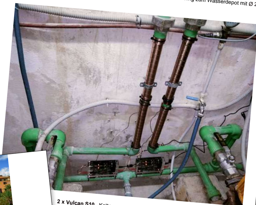
Vulcan 3000 Leitung zum Wasserdepot mit Ø 25mm
