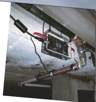
Vulcan 3000 Leitung zum Wasserdepot mit Ø 25mm
