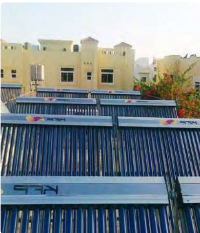
Solar Wasssererhitzeranlage
