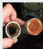
Sistema de tuberías
