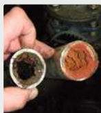
Sistema de tuberías
