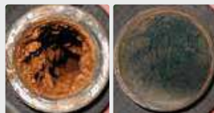
Sistema de tuberías
