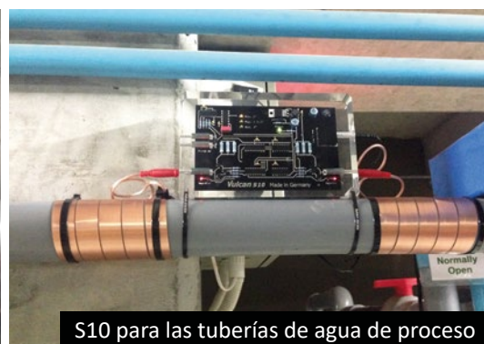
Bandas impulsoras recubiertas de aislamiento para tuberías
