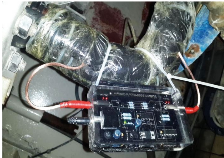
Vulcan 5000 se instaló en la entrada de agua del cuarto de reciclaje de agua.
