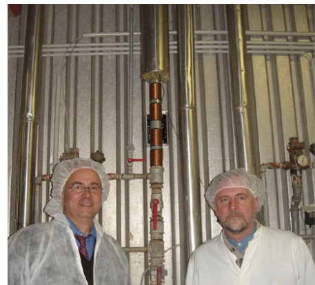
Hr. Christiani bei der Installation von Vulcan
