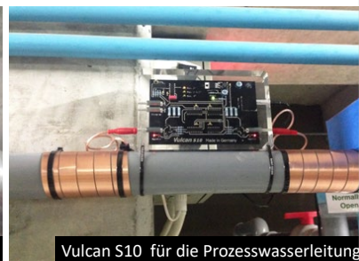
Vulcan Impulsbänder mit Isolierung geschützt
