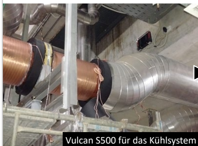
Vulcan Impulsbänder mit Isolierung geschützt
