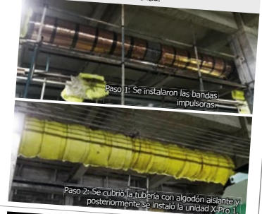
Paso 1: Se instalaron las bandas impulsoras.
