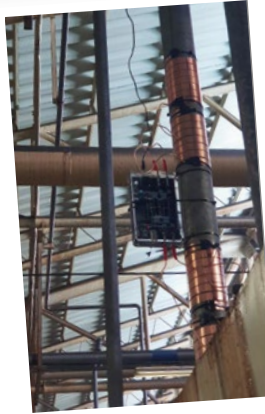
Vulcan S25 se instaló unos 50 metros antes de la máquina de temple por inducción.
