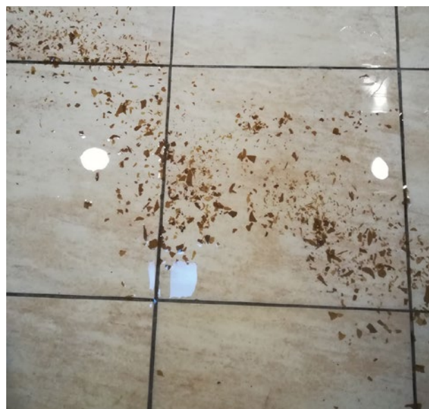
Las incrustaciones fueron eliminadas del vaporizador de la cocina china.
