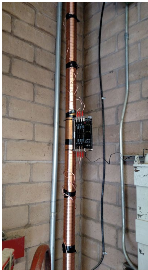
Vulcan S100 an der Hauptwasserleitung installiert
