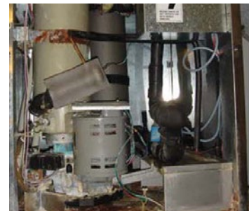
Vulcan schützt die Eismaschine
