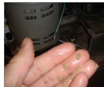
Weiche Kalkablagerungen las- sen sich jetzt leicht entfernen
