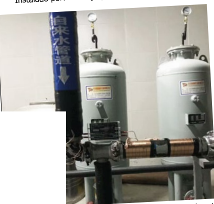
se instaló delante del intercambiador de resolver problemas de incrustaciones en de agua, Vulcan S25 fue instalado
