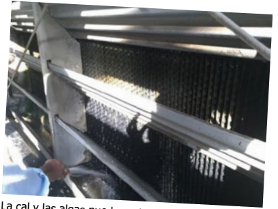
La cal y las algas pueden retirarse fácilmente con una pistola de agua.
