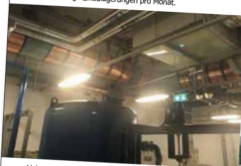
Vulcan S250 und X-Pro 1 wurden an den Hauptrücklaufleitungen des Kondensators installiert.
