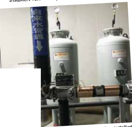
wurde vor dem Wärmetauscher installiert, um die Kalkablagerungen in Wärmetauschern, Durchflüssen und dem gesamten System zu reduzieren.
