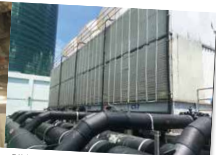
7 Kühltürme wurden mit Vulcan behandelt.
