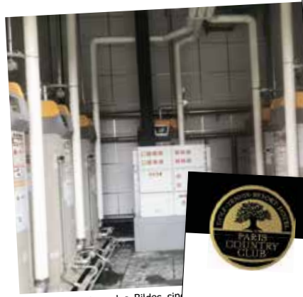
Auf beiden Seiten des Bildes sind die beiden Vulcan S25 Wasserfilter zu sehen, die vor dem Wärmetauscher installiert sind.
