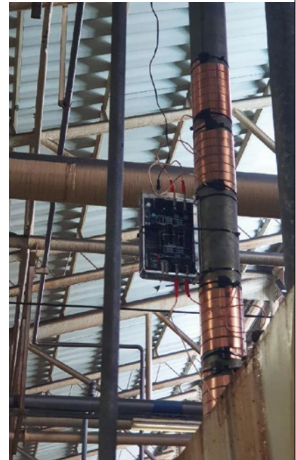
Vulcan S25 wurde etwa 50 Meter vor der Induktionshärtemaschine installiert.
