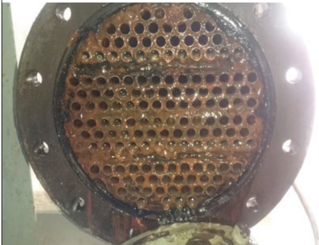
Wärmetauscher vor der Vulcan Installation
