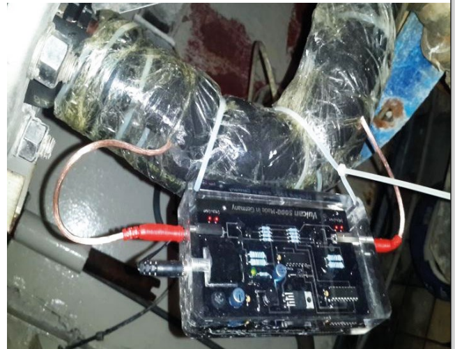
Vulcan 5000 wurde auf der Zuleitung zum Wasserrecyclingraum installiert.
