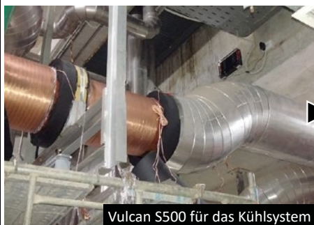
Vulcan Impulsbänder mit Isolierung geschützt
