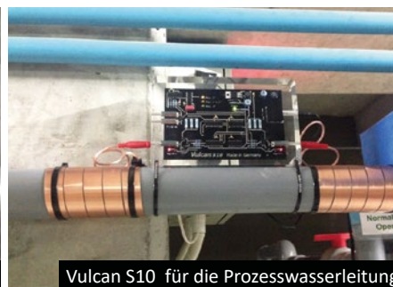
Vulcan Impulsbänder mit Isolierung geschützt
