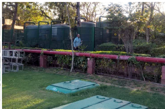
Der salzbasierte Ionentauscher wurde durch Vulcan S100 ersetzt.
