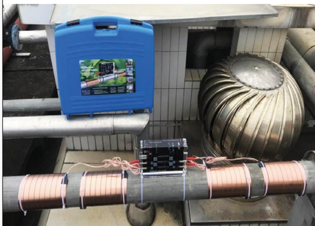
Vulcan S25 wurde an der Hauptwasserleitung des Gästezimmers im Gebäude B installiert.
