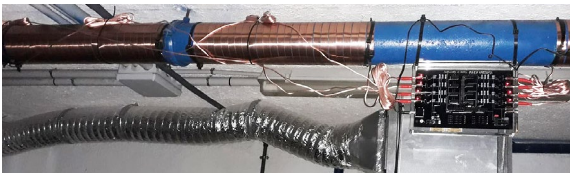
Schritt 2: Installation der Vulcan S250 Einheit auf der Hauptwasserleitung
