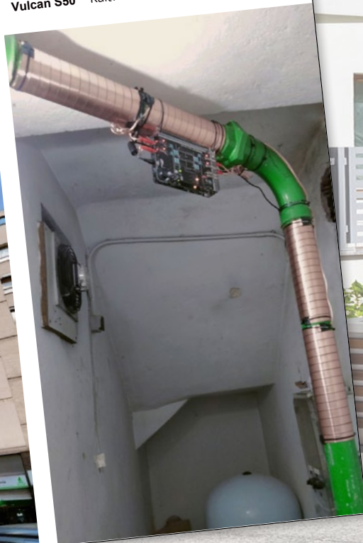
Vulcan S50 Kaltwasser Hauptleitung mit Ø 76 mm
