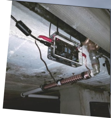
Vulcan 3000 Leitung zum Wasserdepot mit Ø 25mm
