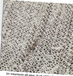
Sin tratamiento del agua, la cal estaba dura como la piedra, ya que no se había limpiado desde hace más de 5 años.
