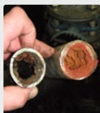
Sistema de tuberías
