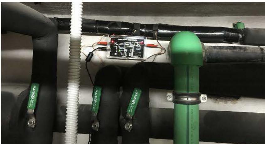
**Vulcan S10** Heisswasser Kreislauf mit  $\varnothing$  63 mm
