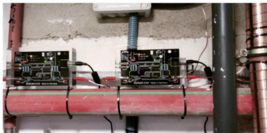
2 x Vulcan S10 en el circuito de agua caliente con  $\varnothing$  32 mm
