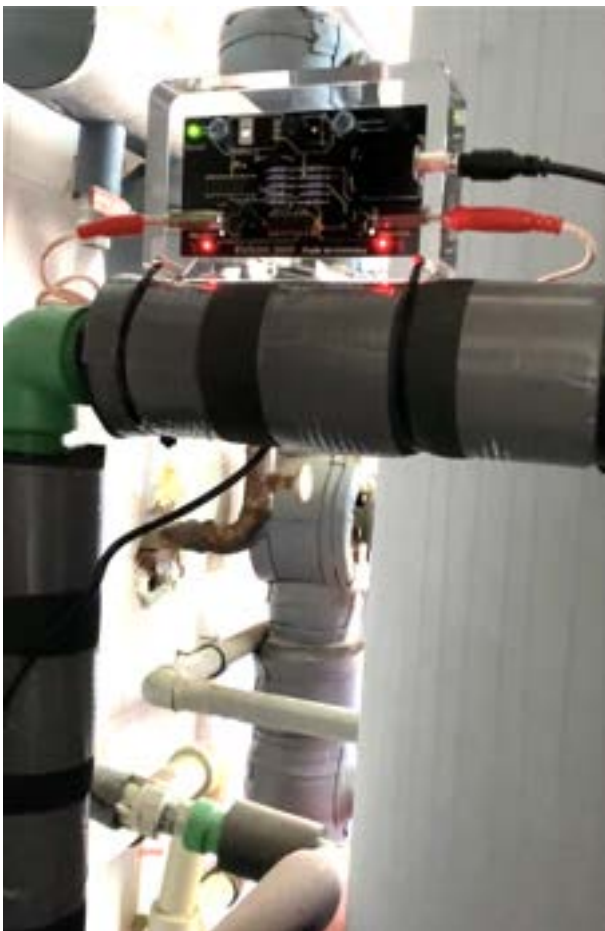
Vulcan 5000 Heiswasser Kreislauf mit Ø 32 mm
