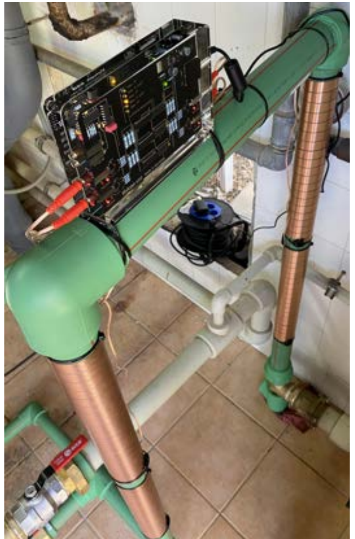
Vulcan 5000 Heiswasser Kreislauf mit Ø 32 mm
