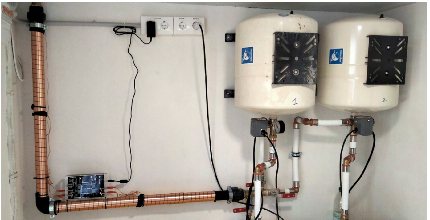
Vulcan S25 en el tubo de agua fría con Ø 50 mm
