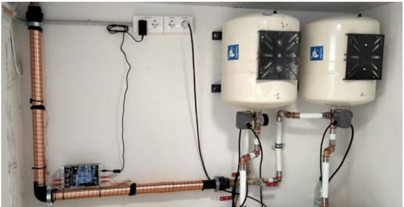
Vulcan S25 Kaltwasser Hauptleitung mit Ø 50 mm
