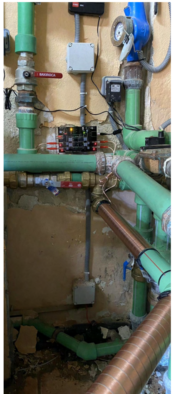
Vulcan S50 en el tubo de agua fría con Ø 63 mm
