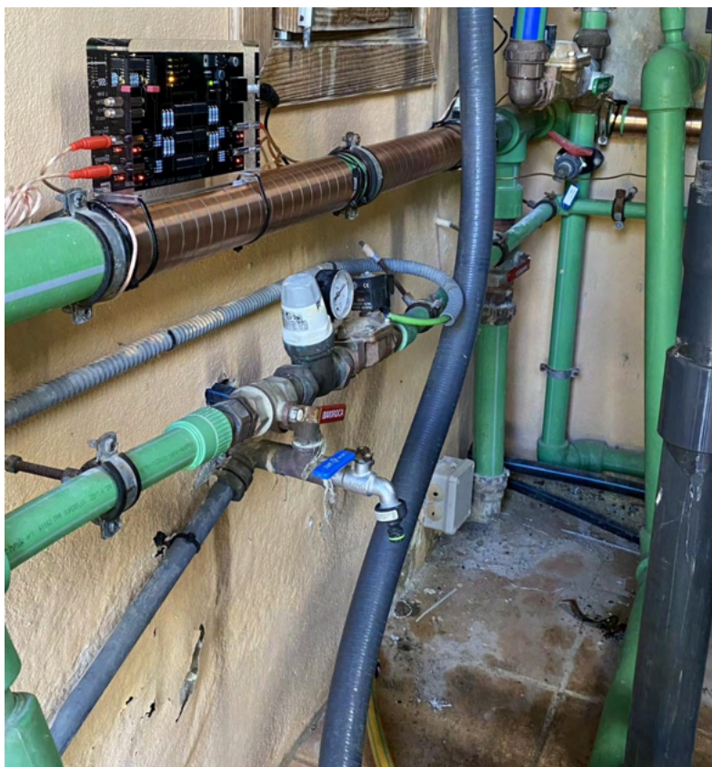
Vulcan S50 an der Kaltwasserleitung mit Ø 63 mm
