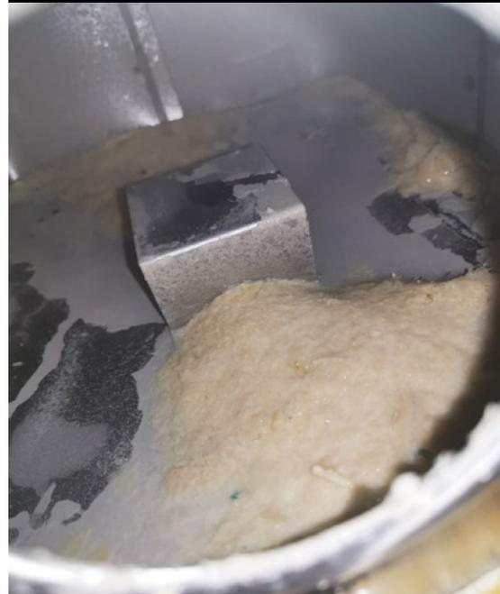
Der Kalk ist zu Pulver geworden, so dass der Dampfgerar nicht mehr zur Reinigung geöffnet werden muss, sondern durch Betätigung der regulären Entleerungsfunktion der Heißwassertank gesäubert werden kann. Aufgrund der guten Ergebnisse wird Vulcan auch in der Warmwasserversorgungssystem und für die zentrale Klimaanlage des Hotels eingebaut.
