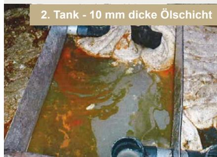
2. Tank - 10 mm dicke Ölschicht
