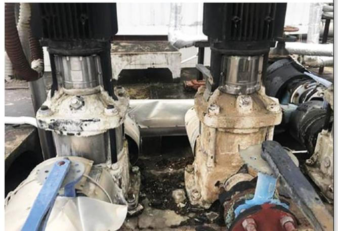
Links ist das Rohr ohne Kalk nach der Installation von Vulcan S25, nach 2 Monaten; rechts ist das Rohr ohne jegliche Wasserbehandlung.
