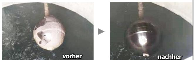
3. Nach 3 Monaten der Installation reinigten wir den Warmwassertank und stellten fest, dass sich eine große Menge an Kalk gelöst hat. Das Foto unten zeigt die aus dem Wassertank entfernten Kalkablagerungen. Auch die Wärmeübertragungseffizienz des Solarsystems hat sich deutlich verbessert, die Leistung ist fast gleich geblieben wie zu Beginn der Installation von Vulcan.
