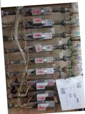
Existen 9 tuberías secundarias pequeñas que cuentan con medidores de agua. Estos fueron instalados para asegurar una tasa de flujo estable. Si el caudal disminuye, se produce un disfuncionamiento en la máquina de temple por inducción, por lo que era necesario limpiar las tuberías manualmente cada 2-3 meses.
